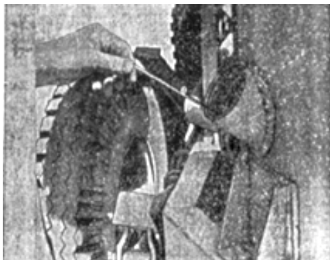
Рис. 44. Проверка уровня масла в маслоотделителе
